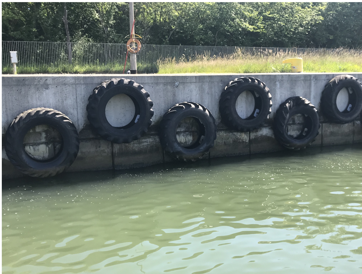
Fot. 3 – linia odbojowa za załamaniem linii nabrzeża (50,00 mb)
