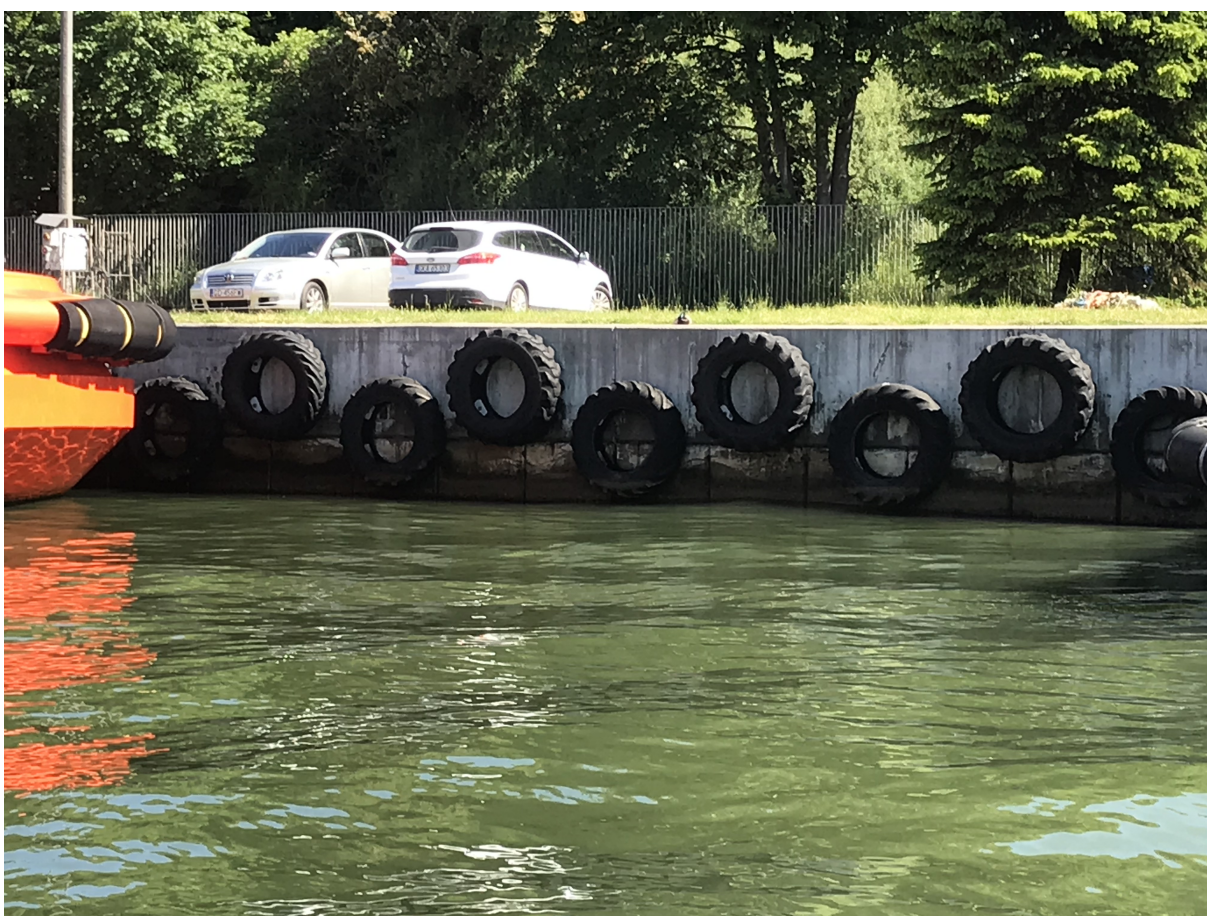
Fot. 6 – linia odbojowa w rejonie cumowania jednostek WUŻ – c.d.
