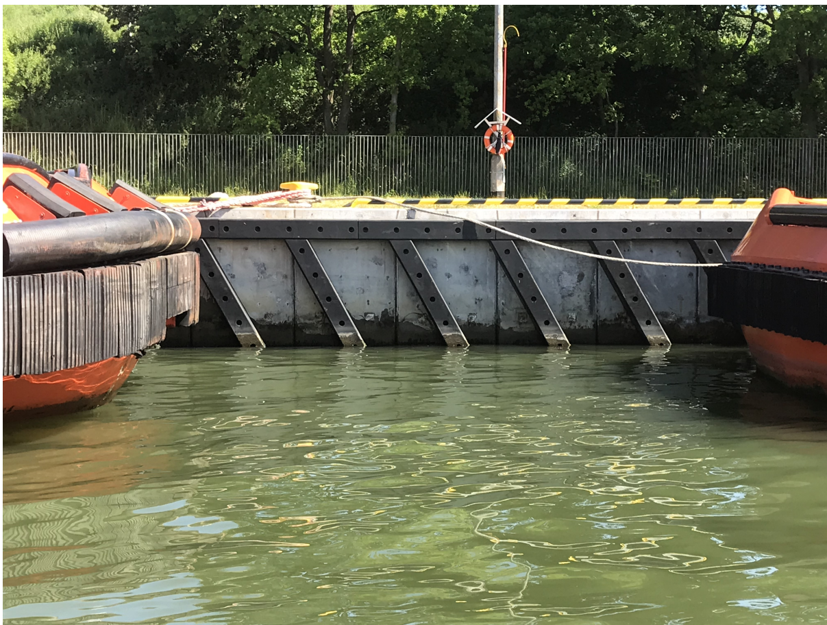
Fot. 5 – linia odbojowa w rejonie cumowania jednostek WUŻ
